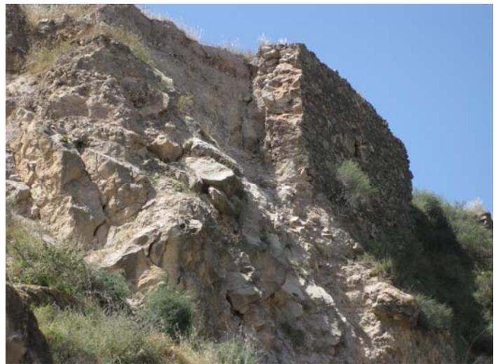
**Figura 5.8.1f.** Vista de detalle de la caída de parte del muro de contención antiguo. Se observa el relleno de intradós que permanece metaestable. Este tipo de inestabilidad también se ha producido en la falda sur del cerro del castillo (ver foto 2.1).
