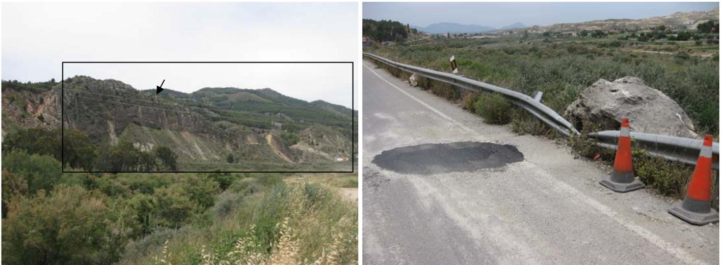
**Figura 5.8.8b** Continuación de la carretera del pantano de Puentes hacia el oeste. A lo largo de la misma se han identificado numerosas inestabilidades, aunque de pequeña entidad. Destaca la caída de bloques con origen en la cresta rocosa controlada por la falla de Las Viñas (señalado con una flecha). En la foto de la derecha se observa un detalle de los daños producidos por la caída de uno de estos bloques.
