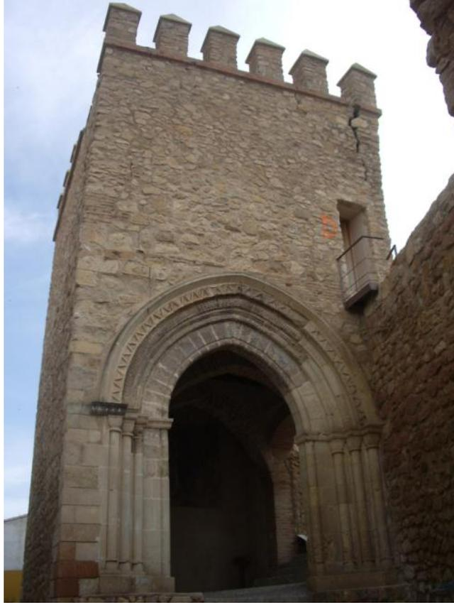
**Figura 6.13.** *Deriva de muro de carga en torre medieval de la muralla*
