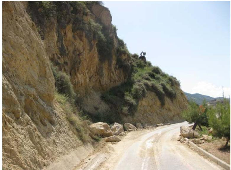
**Figura 5.8.3.** Desprendimiento de rocas en la carretera de subida al castillo.
