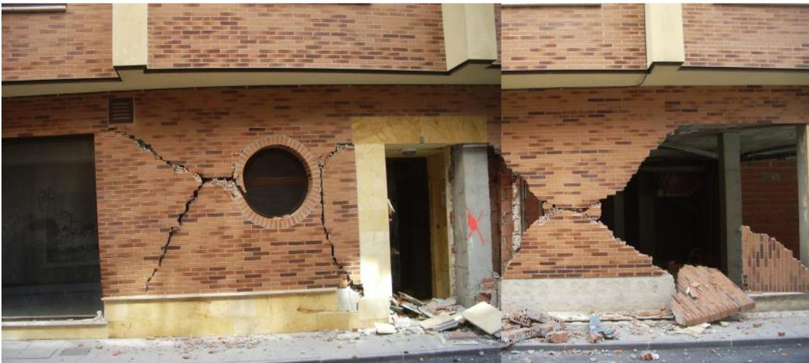
**Figura 6.21.** Daños por cortante en el cerramiento no estructural de planta baja de un edificio de viviendas. El cerramiento ha entrado en carga resistiendo los esfuerzos horizontales de la estructura, por lo que muestra los mismos mecanismos de daño que las estructuras murarias, fallando por cortante con grietas en forma de aspa.
