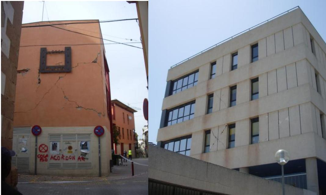
**Figura 6.37.** Grietas por cortante en forma de aspa en el cerramiento de un edificio público de muy reciente construcción en Lorca. A la derecha aspadas de cortante en el hospital Rafael Méndez.
