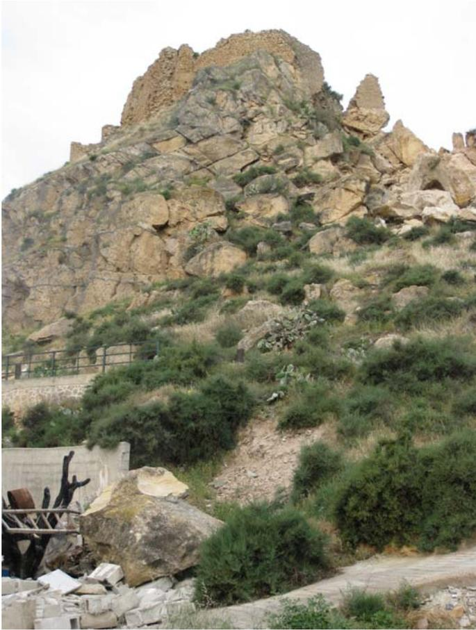
**Figura 5.8.1b.** Vista del lateral S del espolón del cerro del castillo y del bloque que causó la rotura de un pequeño muro. En este tramo la carretera de descenso del castillo sufrió daños moderados en el pavimento. Se observa a la izquierda la terminación lateral de la malla de contención que estabiliza el frente norte del cerro.
