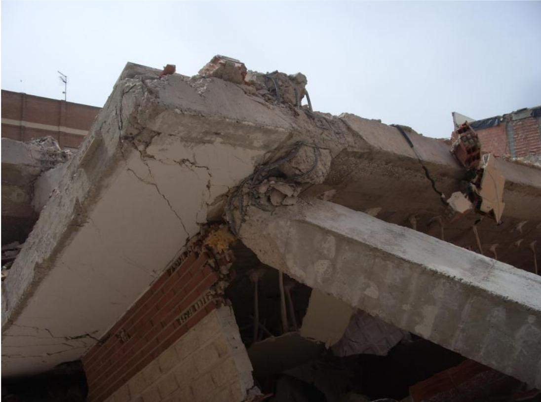
**Figura 6.29.** Detalle del encuentro pilar-forjado del edificio colapsado. Ver figura 6.16 para comprensión de un mecanismo inestable.
