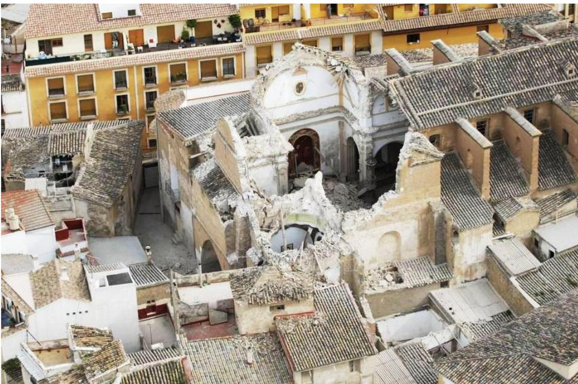
**Figura 6.15.** *Derrumbamiento de la nave de crucero de la iglesia de Santiago.*
