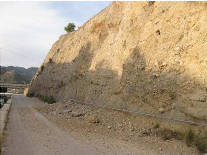
**Figura 5.8.14** Desprendimientos superficiales atribuidos a los terremotos de mayo en un talud de la carretera de servicio del canal Tajo-Segura.
