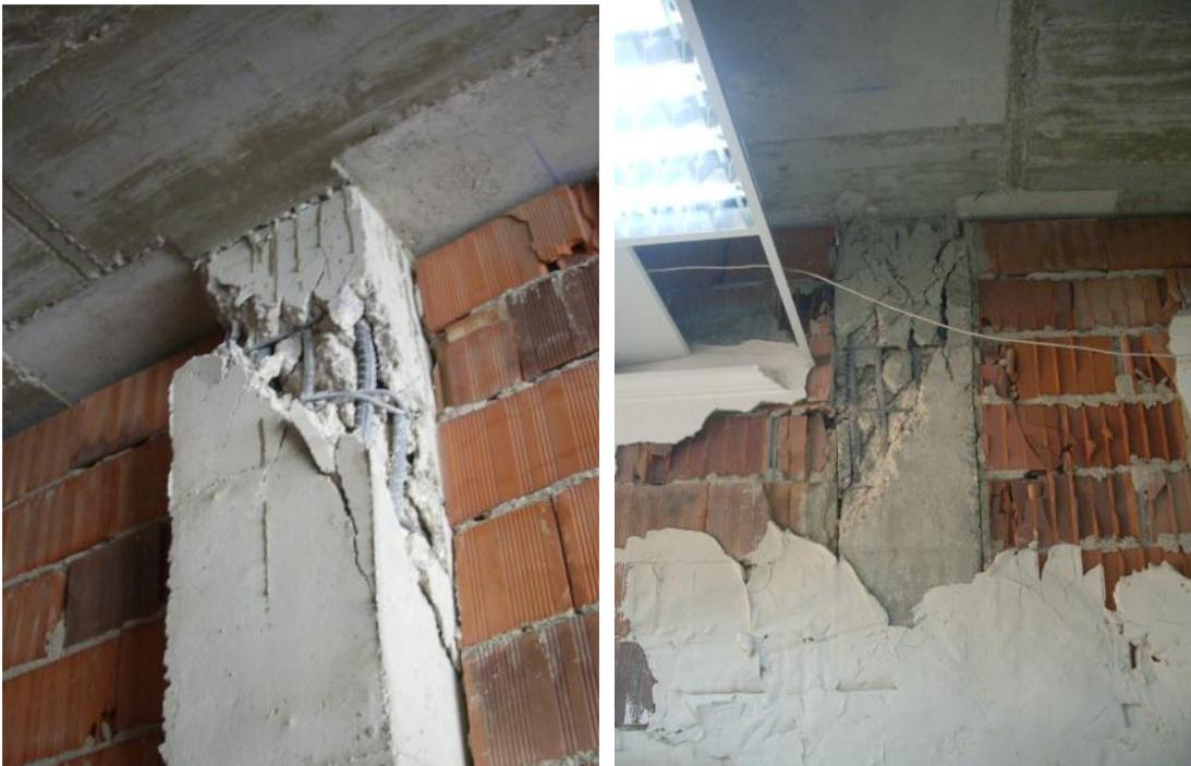
**Figura 6.22.** *Daño frágil por cortante en cabezas de pilares de plantas bajas observados en varios edificios. Esto es un mecanismo inestable de daño de gran peligrosidad.*
