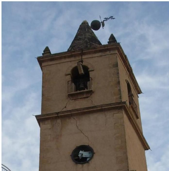
**Figura 6.12.** Daños por cortante en forma de aspa en la torre de la iglesia del paso azul.
