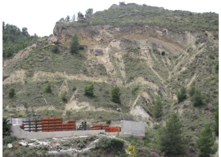
**Figura 5.8.11** Vista de la ladera en un depósito de bombonas de gas en la carretera del pantano de Puentes. No se han identificado inestabilidades del terreno atribuibles a los terremotos del 11 de Mayo, aunque el desplome del murete de bloques de hormigón sí se atribuye a estos.
