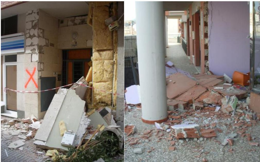
**Figura 6.38.** Fallo de cerramientos no estructurales bloqueando las salidas de edificios o locales.
