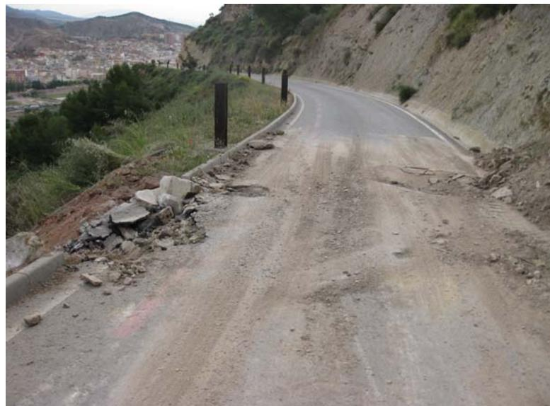
**Figura 5.8.4b.** Daños en el pavimento de la carretera de subida del castillo por la caída y rebote del bloque rocoso de la foto 1.4a.
