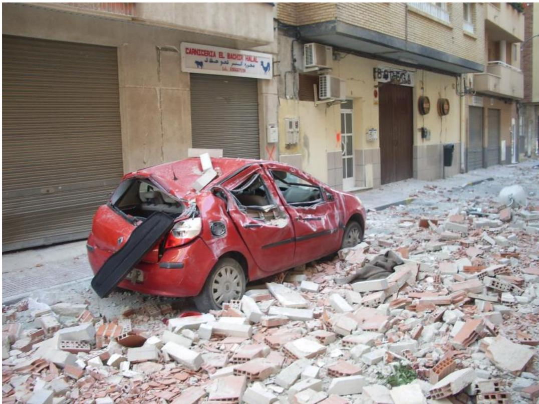
**Figura 6.41.** Un automóvil dañado por la caída de parapetos de cubierta en la Calle Galicia.
