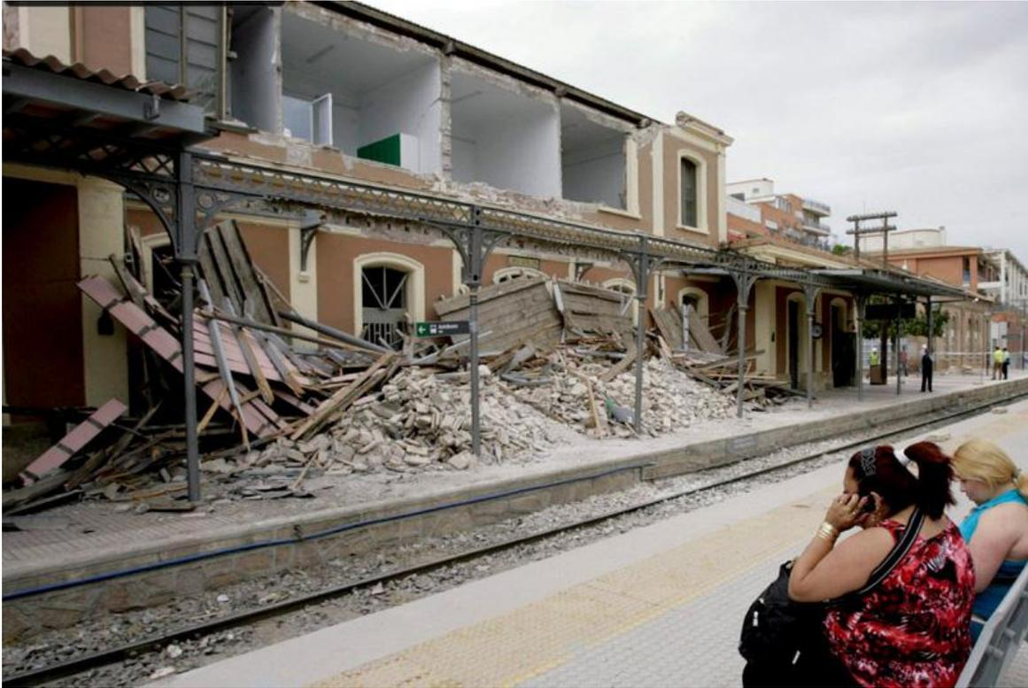
**Figura 6.14.** *Vuelco de estructura muraria de fábrica de ladrillo en la estación de Lorca*
