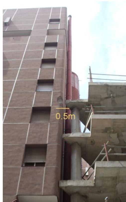
**Figura 6.31.** Los daños concentrados en la tercera planta de este edificio vienen motivados por el confinamiento del edificio colindante más bajo y rígido de la derecha. En edificios altos, el desplazamiento observado ha sido muy grande, indicado por los daños de impacto causados entre los edificios de la imagen de la derecha.
