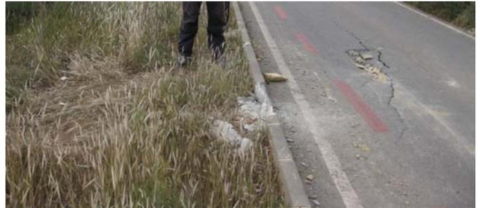
**Figura 5.8.1d.** Daños en la carretera de bajada del castillo causados por el rebote del bloque desprendido del espolón (foto 1.b).
