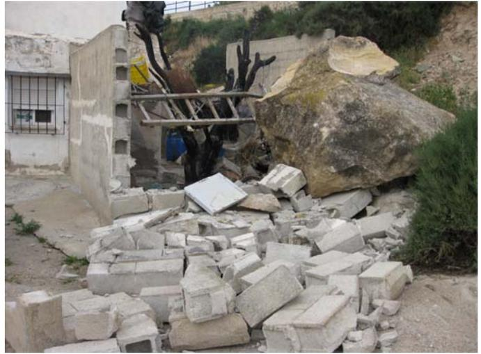
**Figura 5.8.1c.** Impacto en el muro de bloques de hormigón del patio de una vivienda producido por la caída de una roca del espolón.
