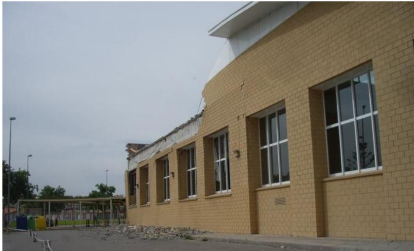
**Figura 6.39.** *Caída de antepecho de bloque sin armar en un edificio dotacional de Lorca.*
