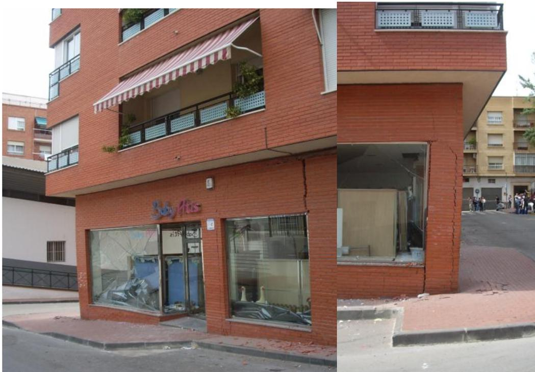
**Figura 6.34.** Torsión motivado por el efecto rigidizante de los muros medianeros de un edificio de esquina con grandes deformaciones permanentes en el pilar de la esquina más alejada del centro de rotación. Este edificio se derrumbó a los pocos días de realizar las fotografías.
