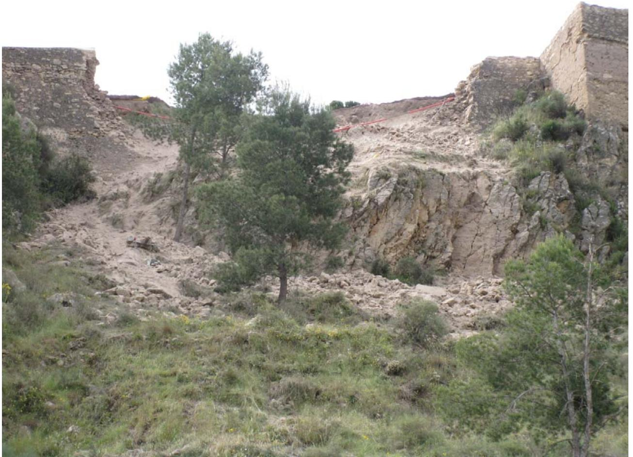
**Figura 5.8.5** Colapso de la muralla exterior del castillo de Lorca (falda N del cerro del Castillo).
