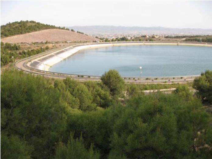
**Figura 5.8.12** Balsa de riego localizada en las inmediaciones de los epicentros de los terremotos del 11 de mayo. No se observó ningún daño ni inestabilidades aparentes en el talud del fondo.
