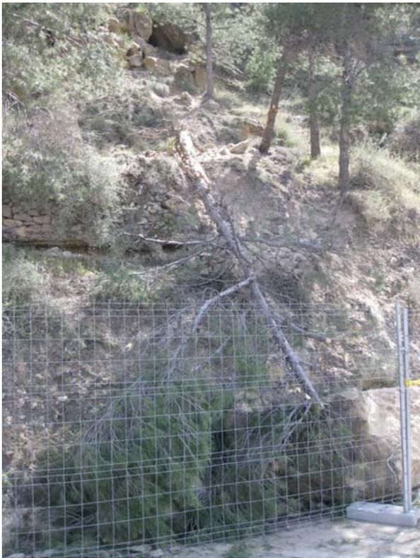
**Fig.5.8.2.** Pequeño desprendimiento con arrastre de un pino. Talud S de la carretera de subida al castillo.
