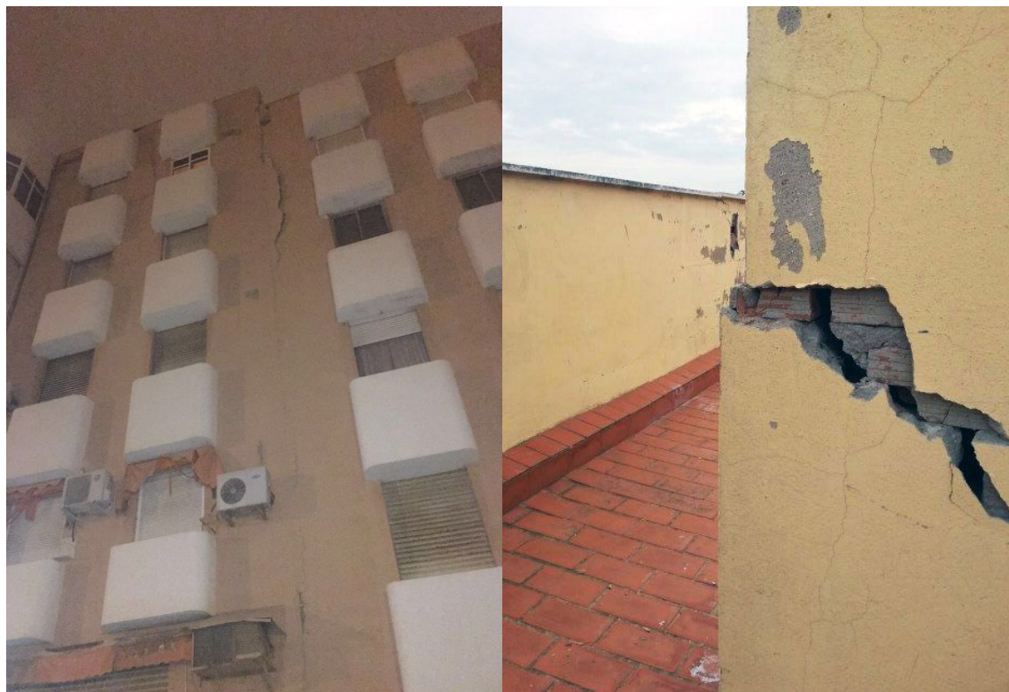
Figura 3. Daños observados en la ciudad de Melilla
