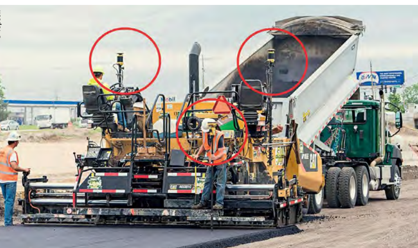
Asfaltado con sensores GNSS.
