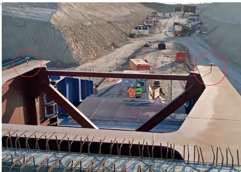
Lanzamiento de puente con GNSS.
