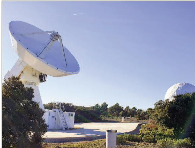
Radiotelescopio RAEGE-VGOS de 13,2 m de diámetro del Observatorio de Yebes. Al fondo se observa el radomo del antiguo radiotelescopio de 14m.
