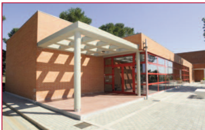
Edificio del Archivo Nacional de Datos Geofísicos
