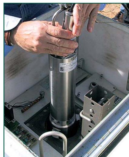
Instalación de sensores sísmicos en Estaciones Sísmicas
