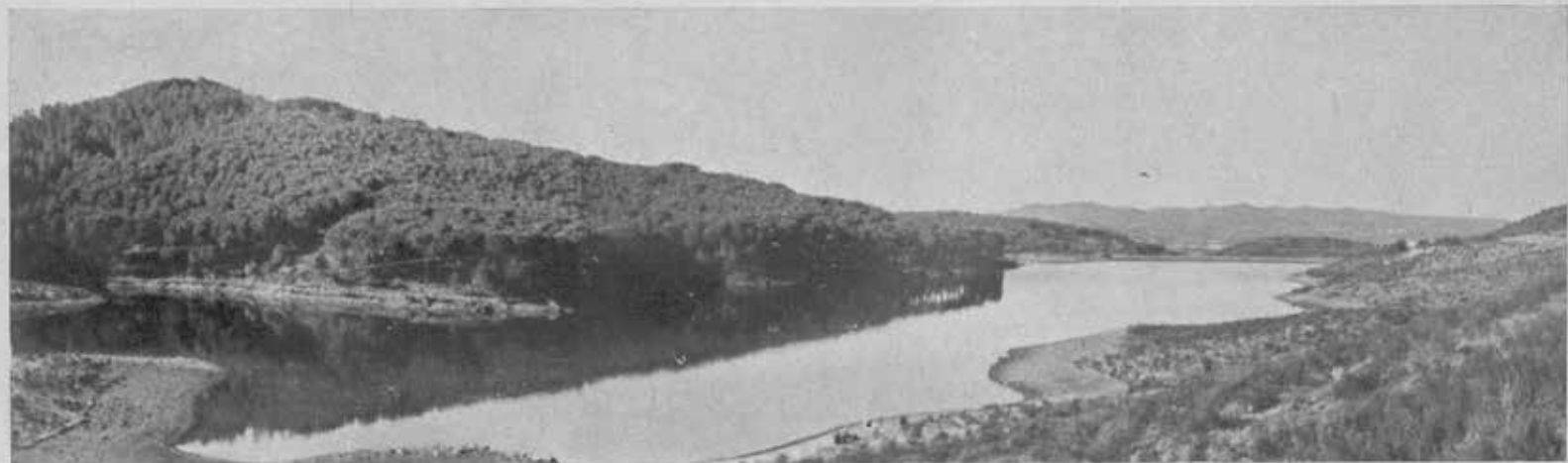
Vista del embalse para la obtención de cobre por cementación en Minas del Castillo de las Guardas.
