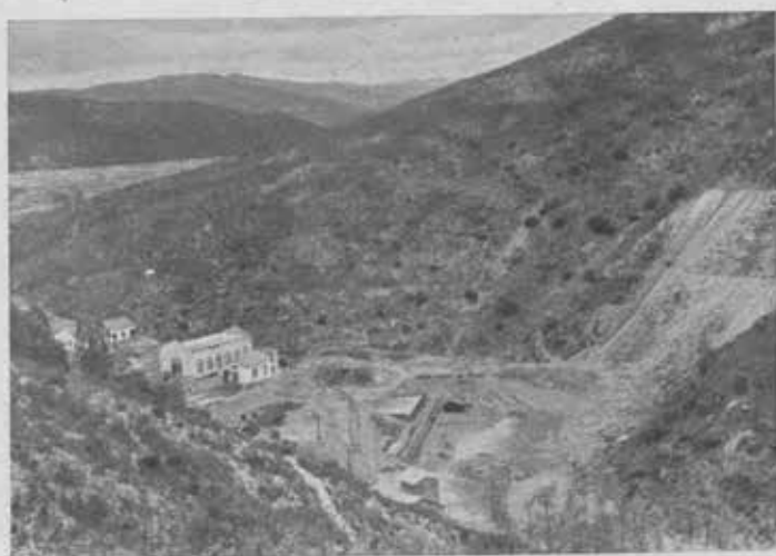
Mina de S. Platon. Central de energía y ferrocarril minero, junto al río Odiel.
