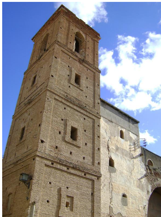
Ilustración 8-1 La torre de la iglesia de la encarnación de Motril, desmochados sus dos cuerpos superiores tras el terremoto del 13 de enero de 1804, persiste en la actualidad. La nueva torre se adosa a la anterior por su lado norte.
