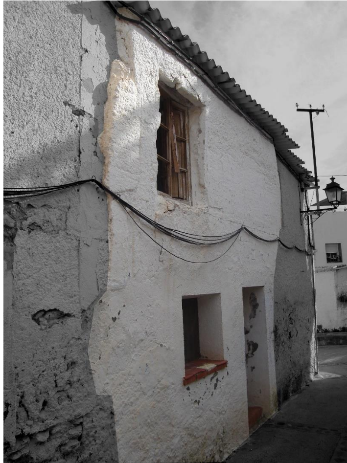
Ilustración 7-4 Antiguo edificio de tapial en Turón
