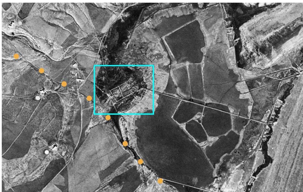
Ilustración 5-10 Cimientos de la Real Salina, vuelo 1956.
