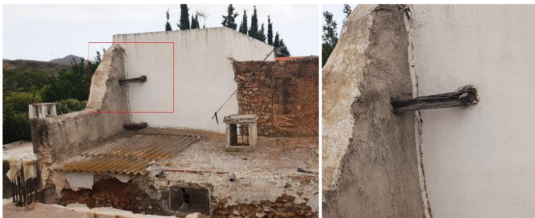
Ilustración 4-7 Aspa y clavo para confinar nuevo testero a muro original de tapial, parcialmente derribado por el terremoto de 1804.
