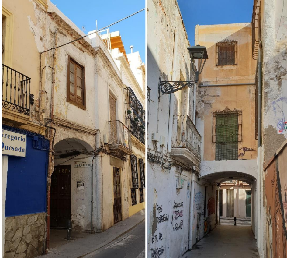
Ilustración 6-5 Arco de entibo existente en Calle Real
