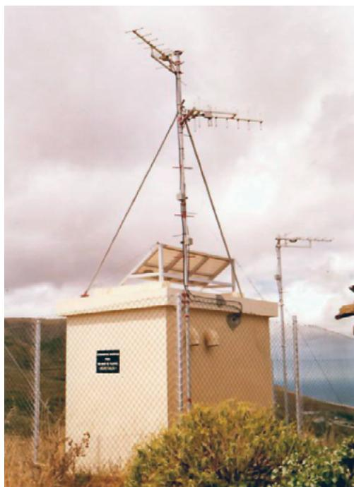
*Figura A1-13. - Estación sísmica GGC de Guía-Gran Canaria (1984-act.). A partir de la instalación de la estación CFTV en Fuerteventura (1985-act.) esta estación enviaba sus datos al centro en Santa Cruz de Tenerife vía radio junto con la señal de la estación sísmica CFTV, haciendo las funciones de repetidor.*
