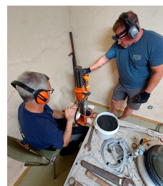
Trabajos de apertura de nuevo pozo en PAB para instalación de sensor STS-6.
