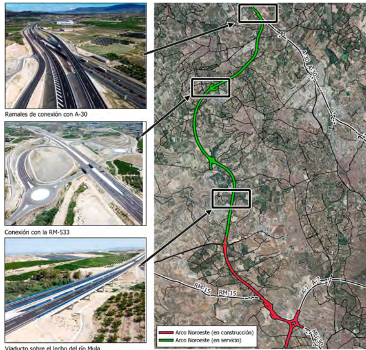
Captura de pantalla de los datos de RT en la zona del Arco Noroeste de Murcia, cuyos tramos A y B, inaugurados el pasado 11 de julio. Imágenes de la izquierda extraídas de https://www.transportes.gob.es/el-ministerio/sala-de-prensa/noticias/vie-11072025-1221 .
