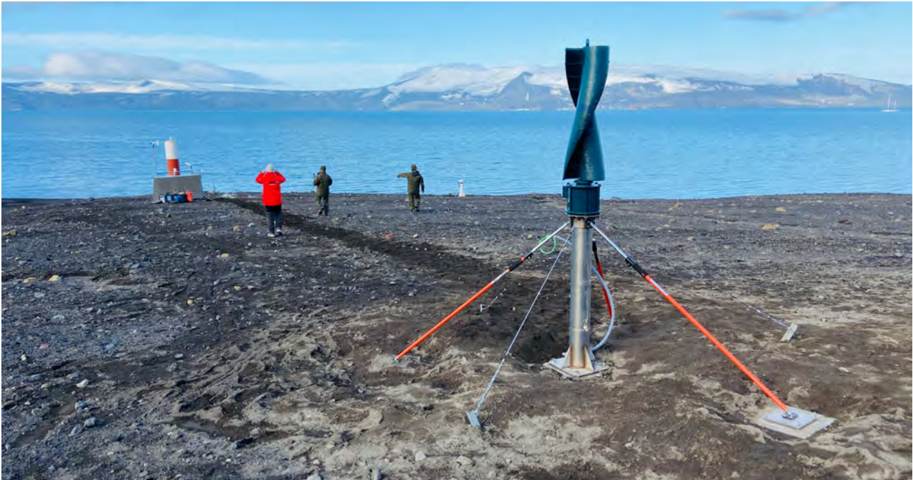
Aerogenerador instalado en la estación de vigilancia volcánica FUM, como complemento a la alimentación eléctrica fotovoltaica que mantiene la estación durante la invernada.
