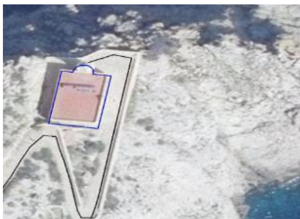
Faro con la señal luminosa en un lateral de la construcción
