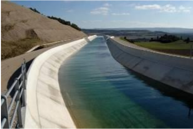
Canal en superficie
