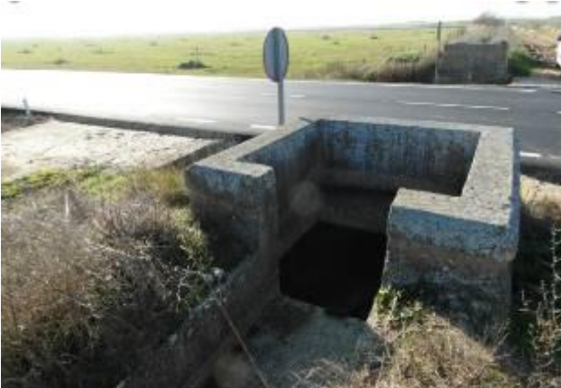
Tramo subterráneo que cruza una vía
