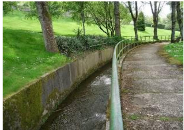
Río canalizado de ancho < 5m
