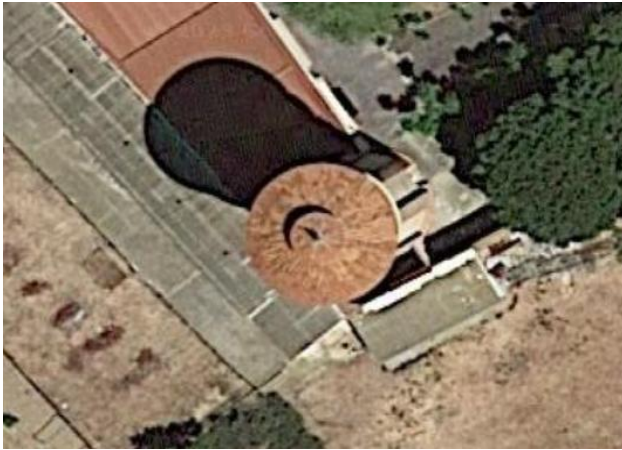
Depósito de agua elevado – vista cenital
