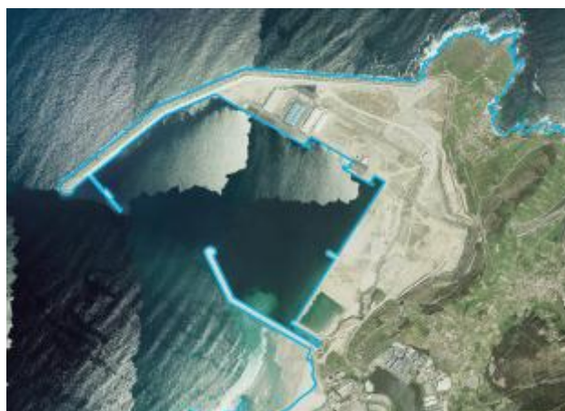
Línea de costa artificial en un puerto
