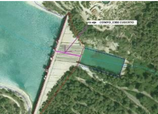
Tramo de río cubierto al atravesar una presa
