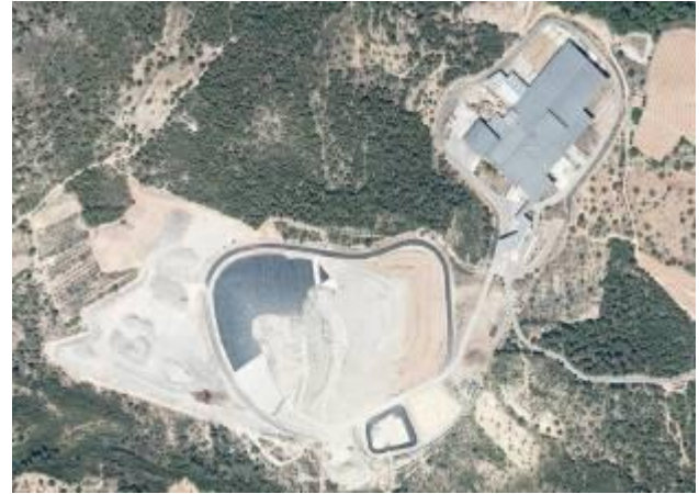
Planta de tratamiento de residuos con vaso de residuos
