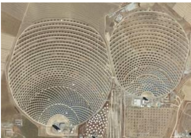
Central termosolar con espejos que concentran a una torre
