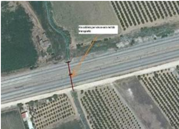
Tramo de río cubierto que cruza una vía
