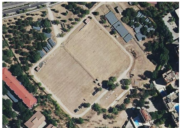
Depósito de agua subterráneo
