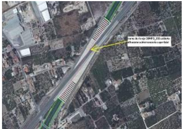
Tramo de río cubierto al hacerse subterráneo
