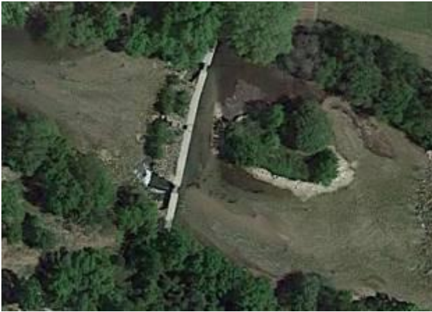
Represa de hormigón en un cauce natural
