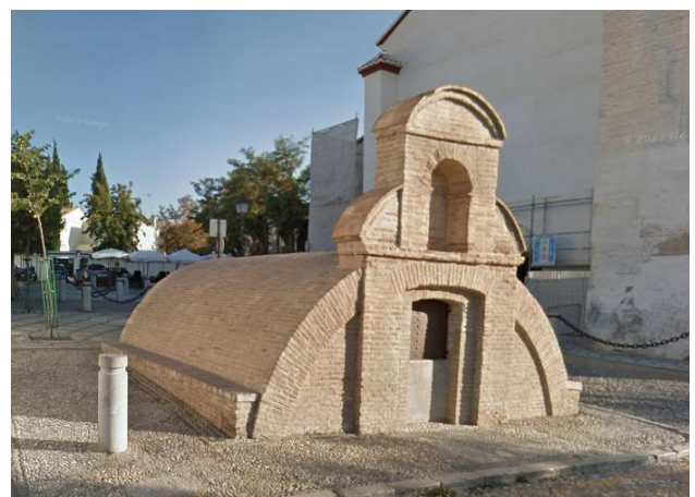
Aljibe capturado como depósito de agua en superficie al tener estructura sobre rasante
