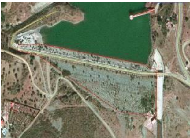
Presa de materiales sueltos (tierra)
