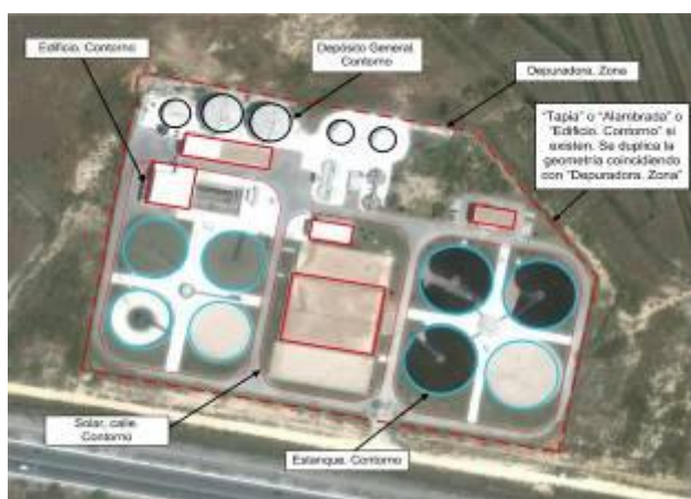
Estación depuradora de aguas residuales (EDAR)
