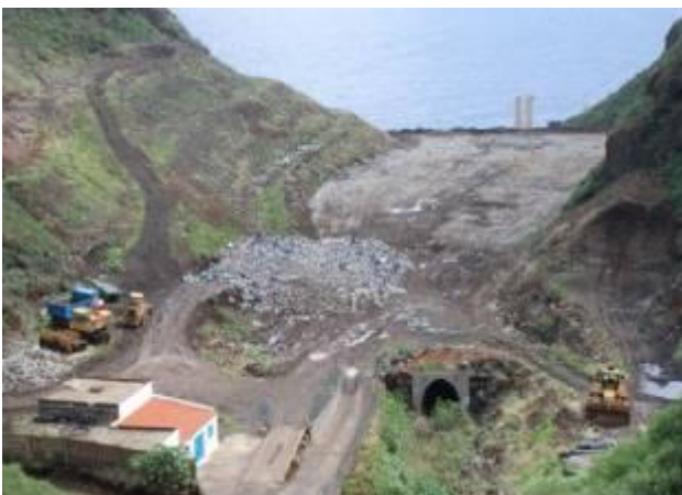
Vaso de residuos sólidos en explotación
