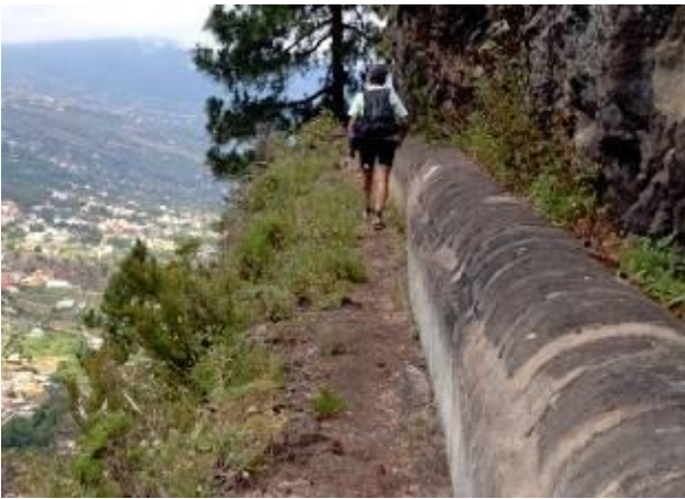
Tubería en superficie
