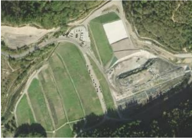
Instalación de gestión de residuos con vaso sellado (izquierda) y vaso en explotación
