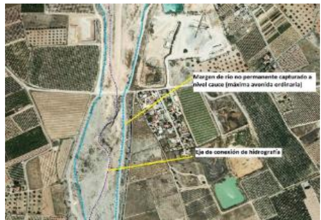
Cauce habitual aparente: tramo con crecidas claramente identificables en el terreno
