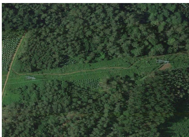
Cortafuegos y línea eléctrica coincidentes
