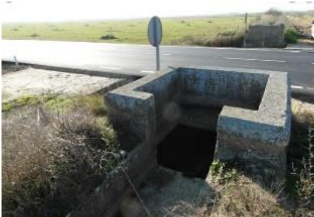
Tramo subterráneo que cruza una vía
