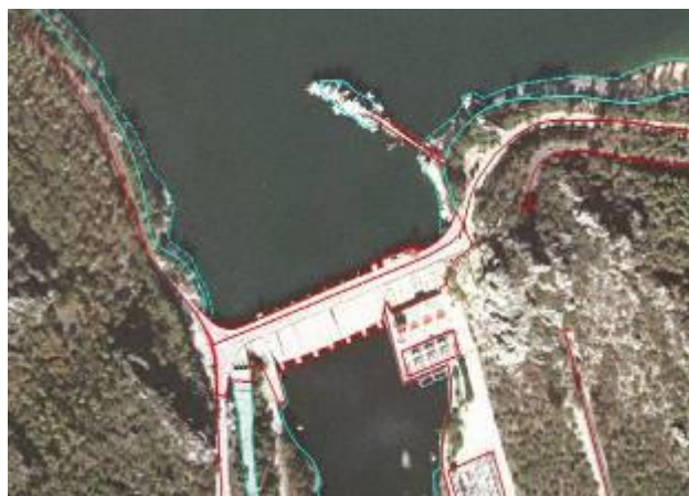
Presa de hormigón
