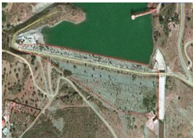
Presa de materiales sueltos (tierra)
