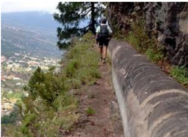
Tubería en superficie
