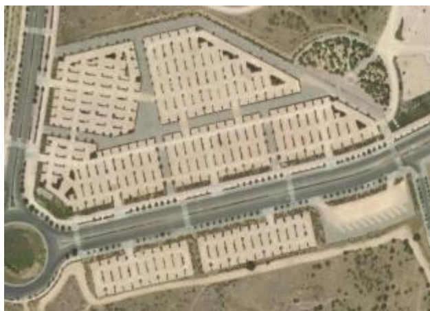
Aparcamiento junto a parque urbano
