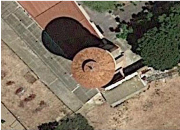
Depósito de agua elevado – vista cenital
