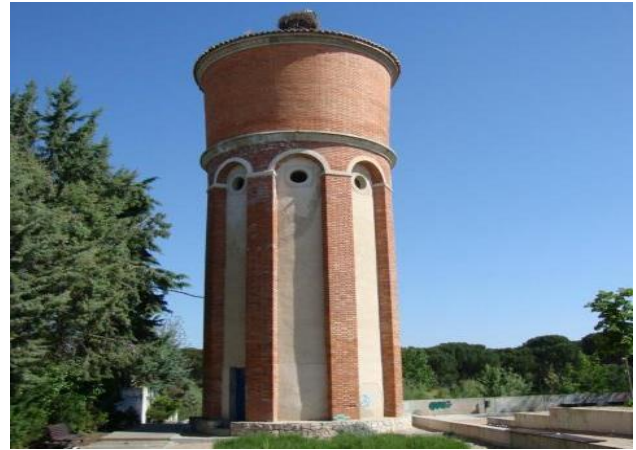
Depósito de agua elevado
