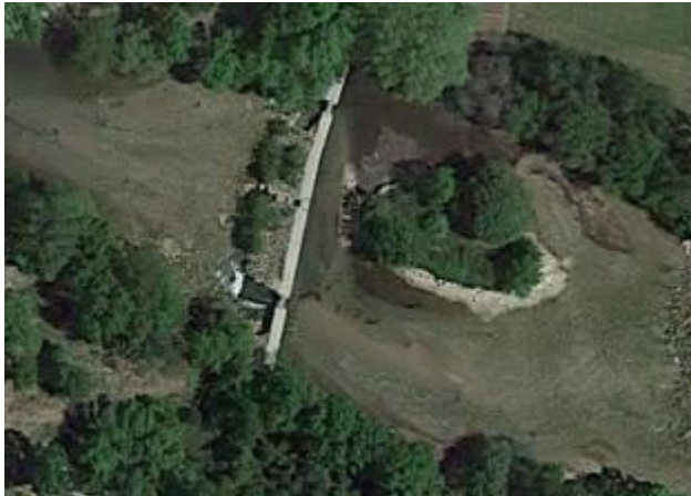
Represa de hormigón en un cauce natural
