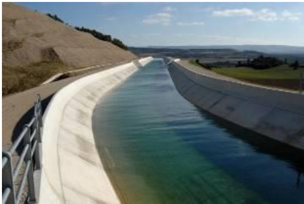
Canal en superficie
