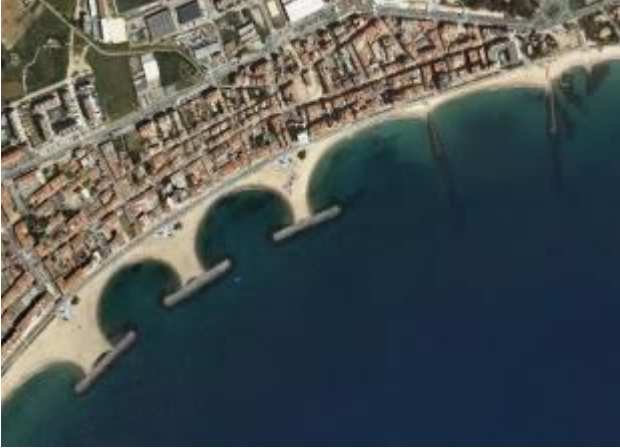
Rompeolas fuera de un puerto, en este caso para proteger las playas
