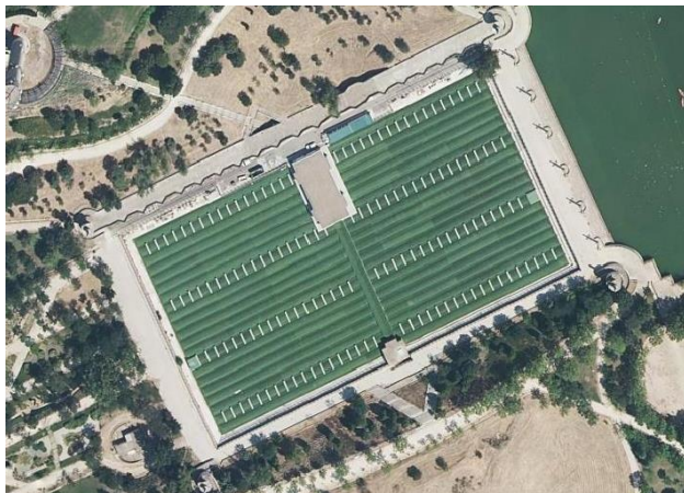
Depósito de agua subterráneo, sin estructura notable sobre rasante
