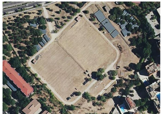
Depósito de agua subterráneo
