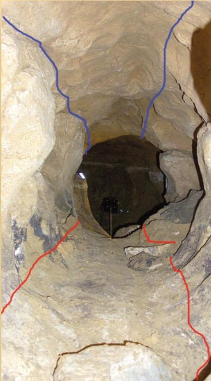
El volumen de puntos para éste tipo de levantamiento topográfico adquirió unas proporciones gigantescas, midiéndose directamente unos 400.000 puntos, que fueron visualizados, analizados y filtrados mediante un programa de CAD para que no quedara ninguna zona por cubrir y evitar duplicados.
