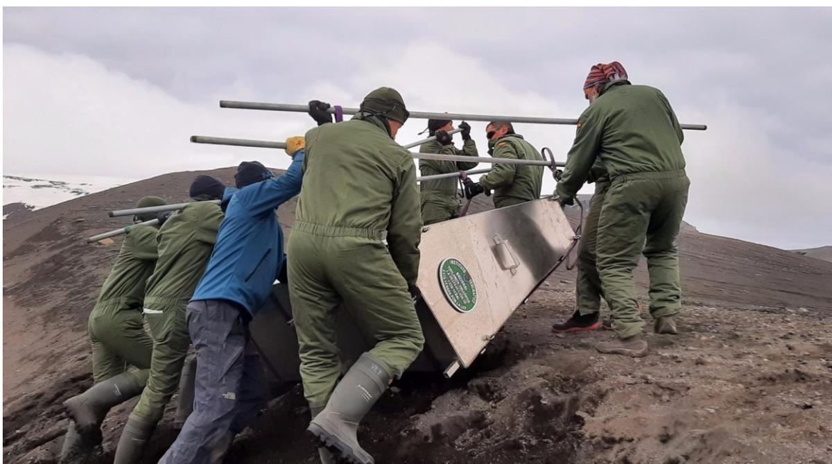
*Traslado manual, hasta su emplazamiento definitivo, de la caseta de una estación sísmica prefabricada en acero inoxidable.*
