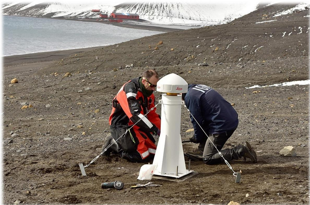
*Instalación de una estación de la red GNSS del IGN para la medida de la deformación en isla Decepción.*
