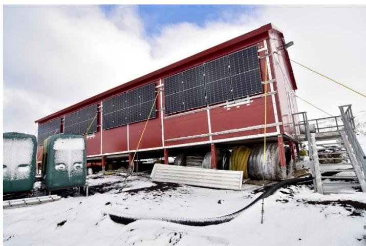
*24 paneles solares, con una potencia total de 10 KW, instalados en la Base Gabriel de Castilla.*
