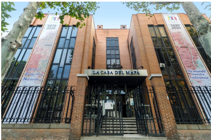
CNIG – edificio principal
