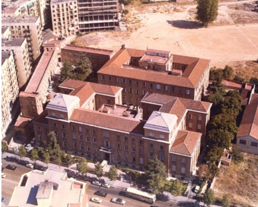
Vista aérea antes de la construcción del edificio del CNIG
