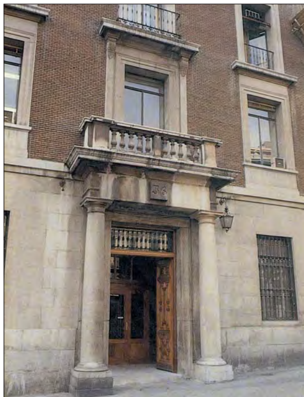
Fachada del edificio de Alcalá, 36 (Madrid), que fue sede de la Dirección de Hidrografía.
