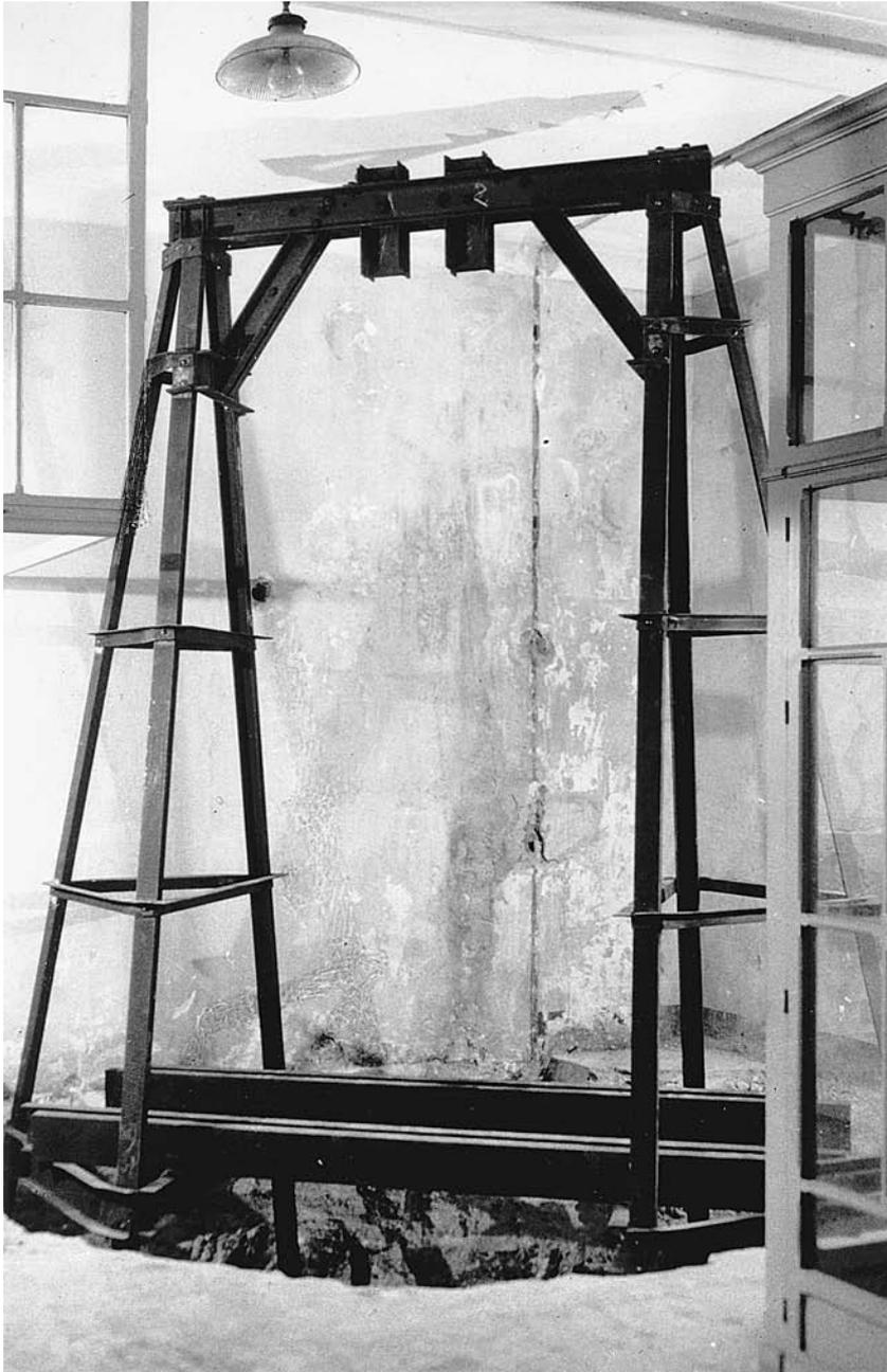
Figura 2.2.16.—No disponemos de ninguna fotografía del sismógrafo Almería vertical. En su lugar, aprovechamos esta oportunidad para reproducir una imagen tomada durante la construcción del soporte para el proyectado sismógrafo de 18.000 kg, coetáneo de éste y que nunca llegó a construirse (fotografía conservada en el Observatorio de Almería).
