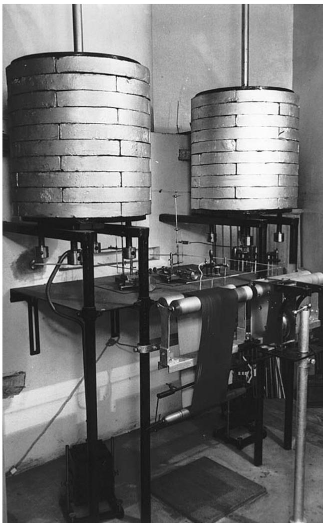
Figura 2.1.15.—Sismógrafos Galbis instalados en el Observatorio Sismológico de Alicante. Las cajas negras que se hallan al pie del instrumento son los amortiguadores (de [Mar54]).
