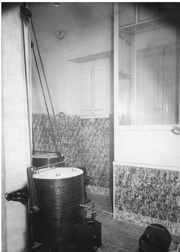
Figura 2.4.16.—Sismógrafo Mainka-Ebro E-W (fotografía conservada en el archivo del Observatorio del Ebro).
