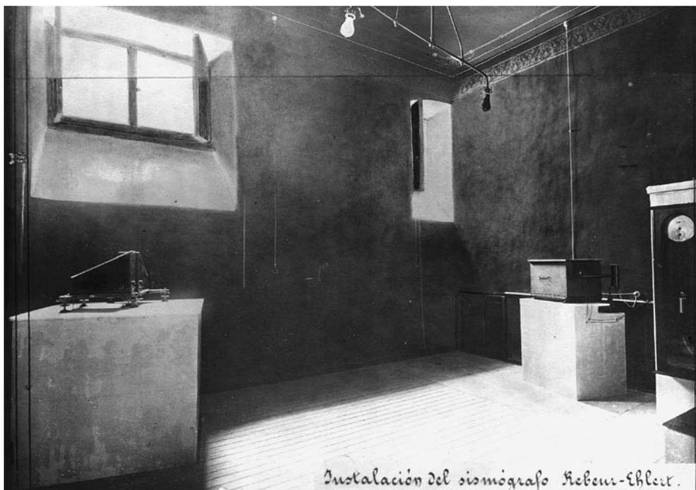
Figura 2.8.16.—Habitación de registro fotográfico del Observatorio de Toledo con los sismógrafos Rebeur-Ehlerth (izquierda) y el tambor de registro (derecha). Siguiendo la costumbre de la época, las paredes estaban pintadas de rojo oscuro (fotografía conservada en el archivo del Observatorio de Toledo).
