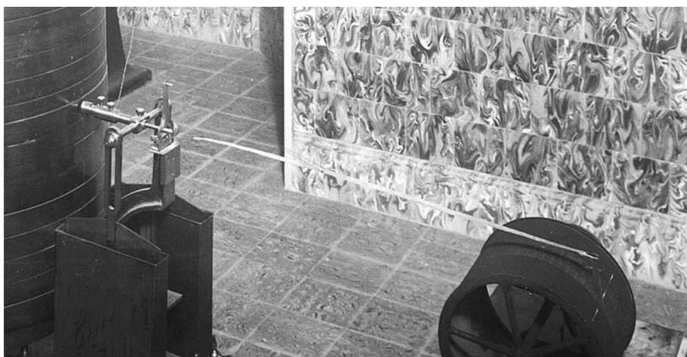
Figura 2.4.17.—Detalle de la figura anterior en donde se aprecia en detalle el mecanismo de la plumilla inscriptora. Véase también la figura 2.4.19.
