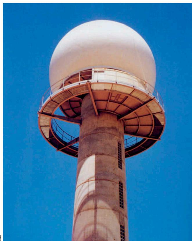
Radar de ruta de La Coruña. La antena giratoria se encuentra en el interior del radomo
