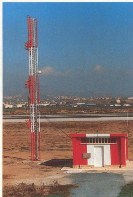
Caseta que contiene el emisor UHF de la senda de planeo de un ILS y sistema de antenas
