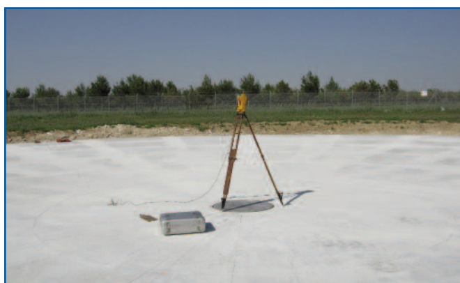
Trabajos de determinación de la Rosa de los Vientos en el aeropuerto de Los Llanos (Albacete)
