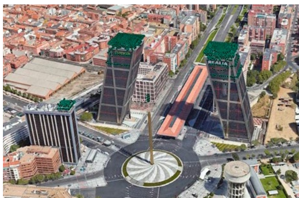
Identificación de obstáculos en las Torres Kio en Madrid
