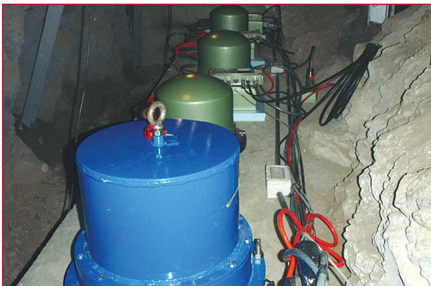
Bajada de la instrumentación y colocación de la misma.
