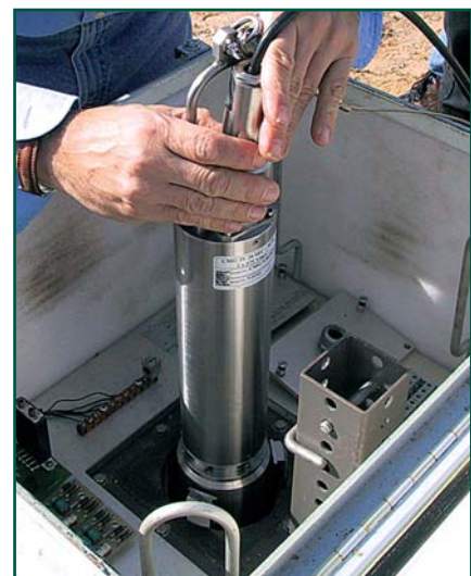
Instalación de sensores en Estaciones Sísmicas
