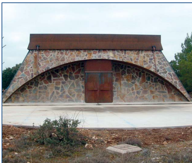
Vista exterior del Pabellón de Gravimetría del Observatorio de Yebes
