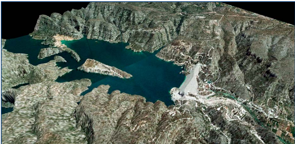
Vista en 3D de la Presa de Tous, superponiendo la ortofoto al Modelo Digital de Superficies Lidar
