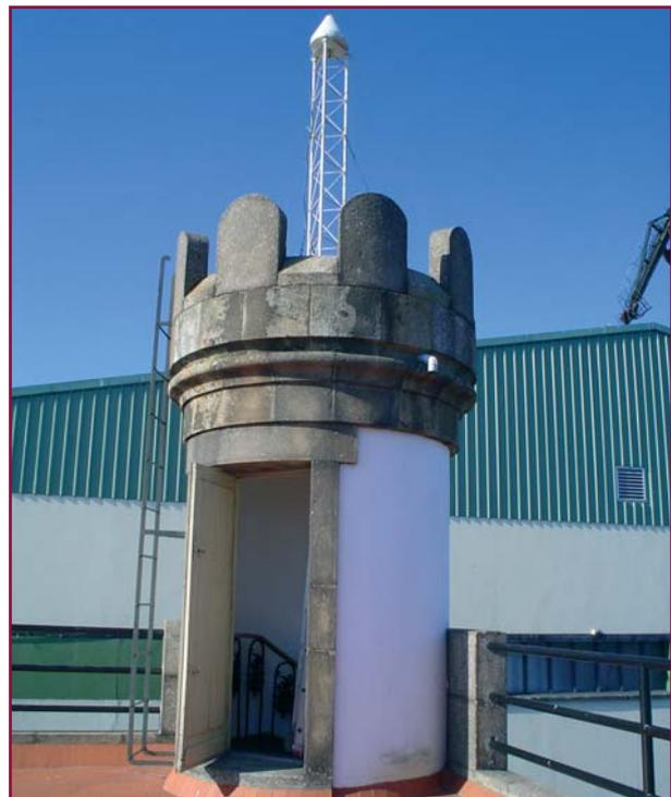
Antena de la estación permanente de la Red EGNSS situada en el mareógrafo de A Coruña
